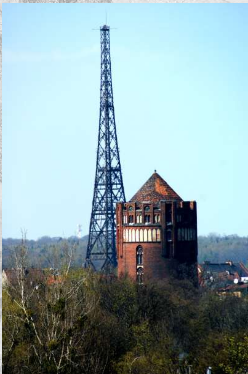
Na zdj.: wieża ciśnień na Zatorzu. W tle radiostacja gliwicka. Fot.: autor.
