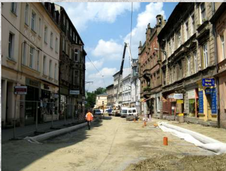
Na zdj.: remont ul. Wieczorka. Fot.: autor.
